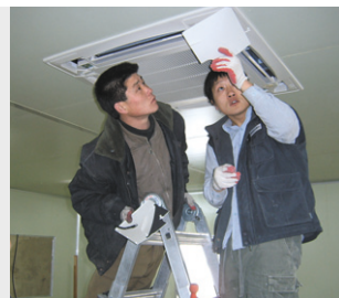
품질관리실 냉난방기 설치중인 남북기술자
