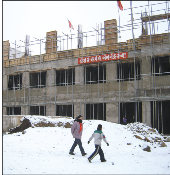
남도산원 신축공사 현장, 첫눈에 즐거운 아이들
